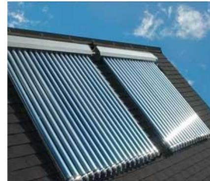
Figure 41 : Capteurs sous vide<sup>266</sup>
