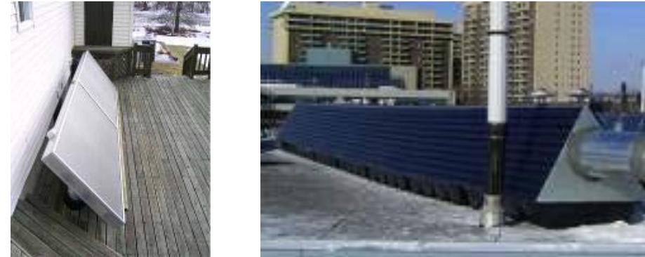
Figure 38 : Capteurs vitrés (gauche) et capteurs à plaques métalliques (droite)<sup>254</sup>
