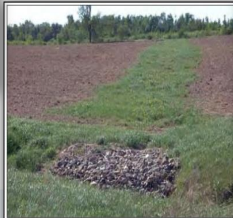
Photo 21 : Rigole engazonnée en bon état Source : Ferme Louis d'Or
