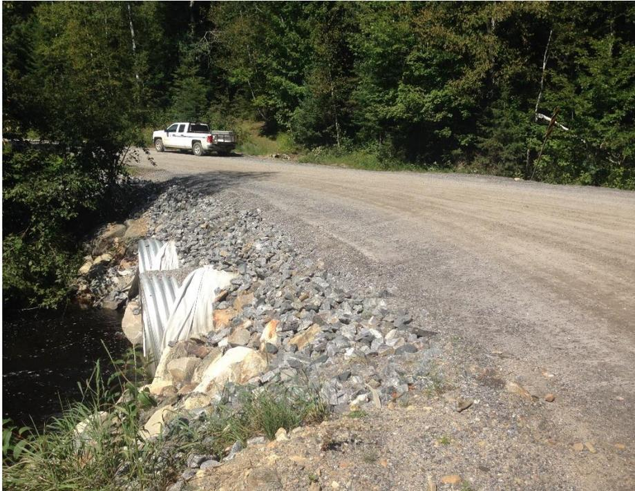
**Figure 21. Exemple d'un foyer d'érosion observé sur le chemin du lac Chaud, qui traverse le ruisseau Brochet**
