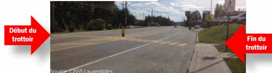
Trottoir interrompu du secteur 3, Rivière-Rouge
